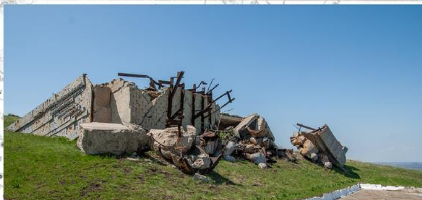
Разрушенный пилон «Авиация». 2021 г.
