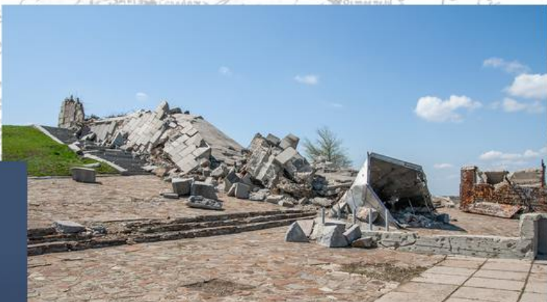
Разрушенная стена мемориального комплекса «Саур-Могила». 2021 г.
